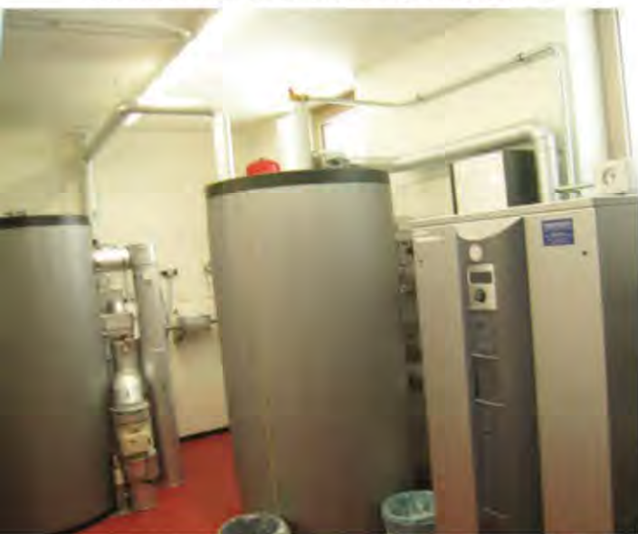
Αποψη των εγκαταστάσεων που περιλαμβάνουν γεωθερμική αντλία θερμότητας και σύστημα συμπαγωγής θερμότητας και ηλεκτρισμού με χρήση φυσικού αερίου για την κάλυψη των ενεργειακών αναγκών των κτηρίων του συνεταιρισμού κοινωνικής κατοικίας στο Βερολίνο.
