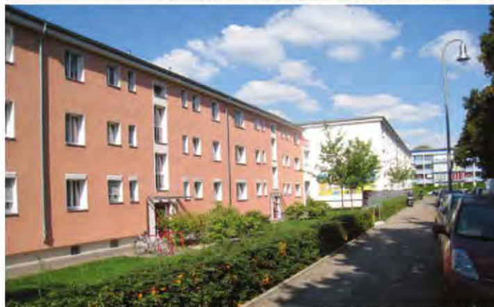
Αποψη κτηρίων του συνεταιρισμού κοινωνικής κατοικίας στο Βερολίνο που έχουν μετατραπεί σε “κτίρια σχεδόν μηδενικής ενεργειακής κατανάλωσης”. Η ενεργειακή τους αναβάθμιση επετεύχθη με τη χρηματοδότηση της Γερμανικής αναπτυξιακής τράπεζας KfW.
